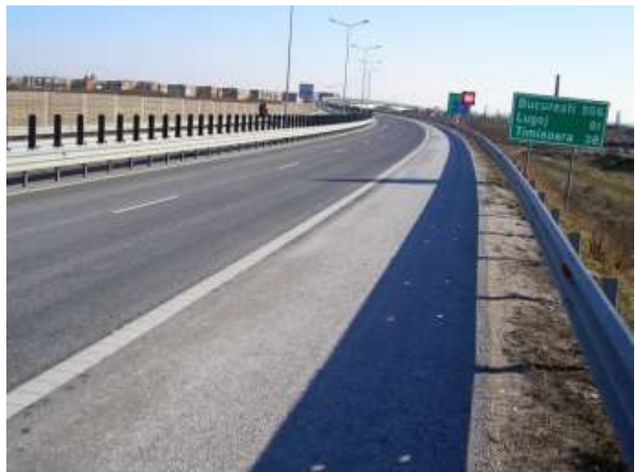
Autostrada A1 (tronsonul Arad-Nădlac-Timișoara) – Sursa: captură proprie, 2015
